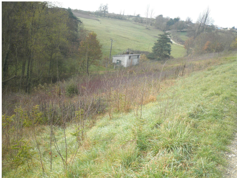
Figure 7 : Digue de fermeture de la retenue qui a été l'objet de travaux de débroussaillage et de tronçonnage d'arbres
