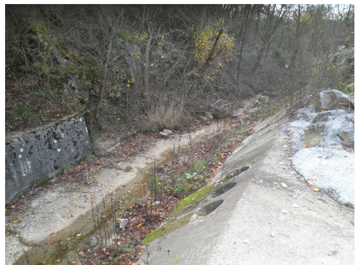
Figure 6 : Grille d'évacuation communiquant avec la buse passant sous la plate-forme bétonnée pour l'évacuation des petits débits (à gauche), et exutoire des buses d'évacuation dans le canal béton du déversoir (à droite)
