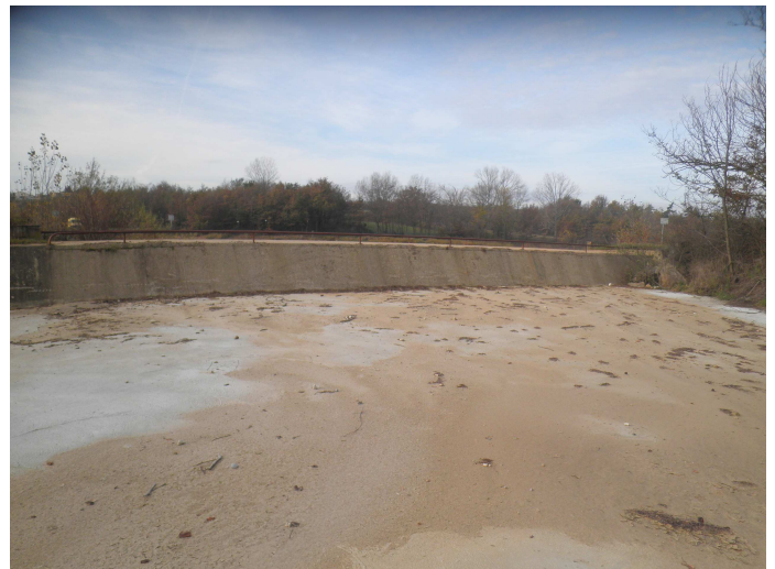
Figure 5 : Digue de débordement du déversoir d'orage (à gauche), et plate-forme en béton du déversoir (à droite)
