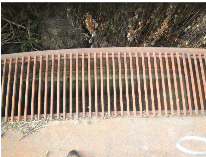
Figure 6 : Grille d'évacuation communiquant avec la buse passant sous la plate-forme bétonnée pour l'évacuation des petits débits (à gauche), et exutoire des buses d'évacuation dans le canal béton du déversoir (à droite)
