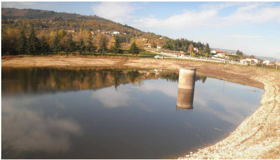
Figure 5 : Tour assurant le prélèvement dans le plan d'eau - photo du 15/11/11
